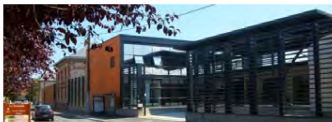
Locaux du siège à Saint-Pryvé Saint Mesmin (45)
