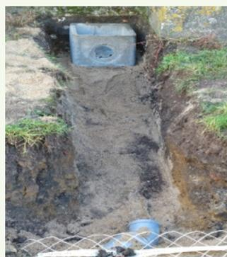
Cela a nécessité un terrassement en tranchées autour de l'église, la mise en place en fond de fouille de tuyaux de canalisation en PVC et la pose de récepteurs d'eau pluviale avec tampon au pied de chaque contrefort.
