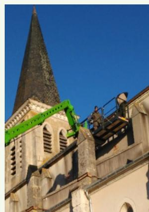
La première tranche de travaux porte principalement sur l'assainissement de la toiture et la prolongation du réseau d'assainissement devant recevoir les eaux pluviales de l'église.
